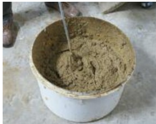
Utilizarea unui agitator mecanizat înlesnește amestecarea tencuiei pe bază de lut
