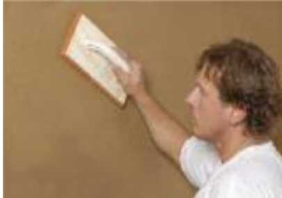
Împâslirea tencuielii superioare pe bază de lut ProCrea® cu o drișcă cu burete aspru.
