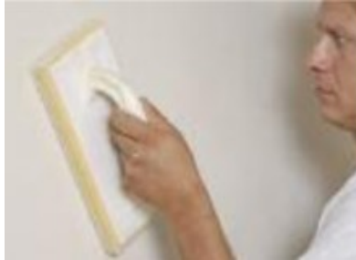
Împâslirea tencuielii nobile pe bază de lut ProCrea® cu o drișcă cu burete fin.
