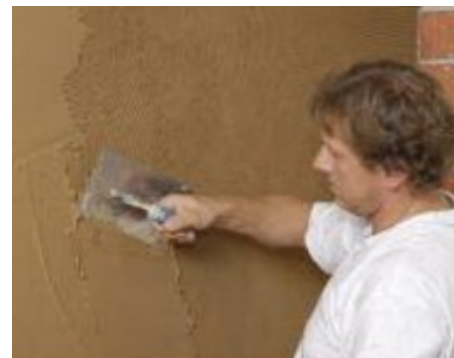
În continuare, suprafața se netezește pentru aplicarea ulterioară a tencuielii superioare.
