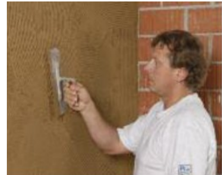
Tencuiala inferioară se aplică pe perete cu o drișcă cu dinți.
