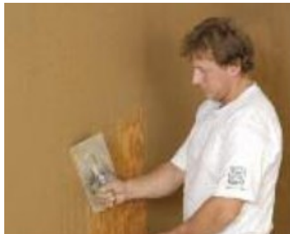
Plasa de armare se apasă cu drișcă în tencuială.
