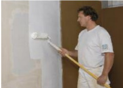
Aplicarea grundului cu o rolă
