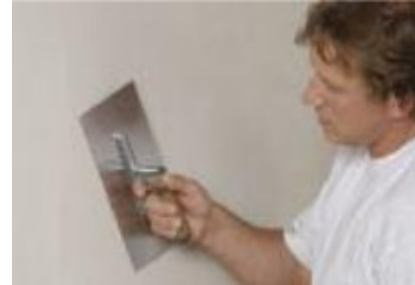
Prelucrarea tencuielii nobile pe bază de lut ProCrea® cu drișca rezultă o suprafață extrem de netedă.
