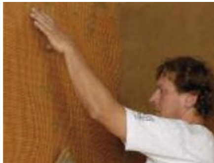
Plasa de armare se așează în tencuiala de lut proaspăt aplicată.
