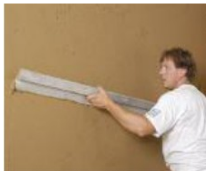
Nivelare cu un dreptar.
