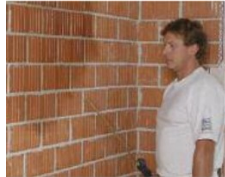
În funcție de natura substratului, este nevoie de umezirea prealabilă a suprafeței
