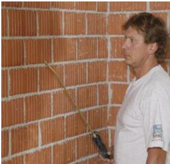
Aplicarea unei soluții de fluorură de calciu împiedică penetrarea rosturilor la zidăriile proaspăt realizate.
